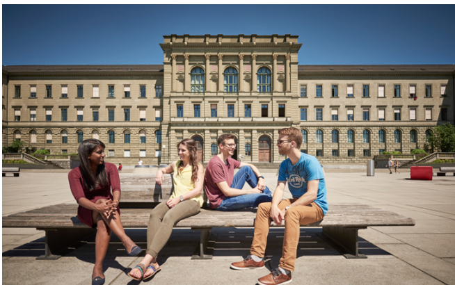
Aussenräume mit Aufenthaltsqualität zu schaffen, ist ein Ziel, wenn die ETH Zürich baut. (Bild: ETH Zürich)
